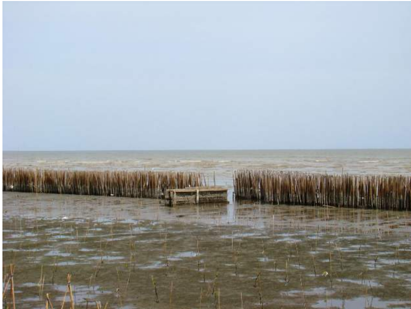
ภาพ : แนวป้องกันการกัดเซาะชายฝั่งทะเล (ใช้ลำไม้ไผ่)
